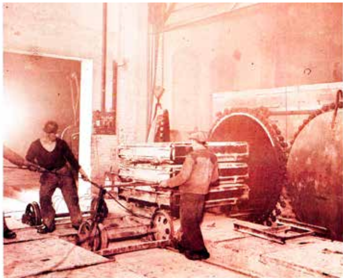
Da produktionen af Gasbeton startede, var det en besværlig arbejdsproces. Blokkene blev "udskåret" med stålplader, og autoklaverne skulle lukkes med bolte.
